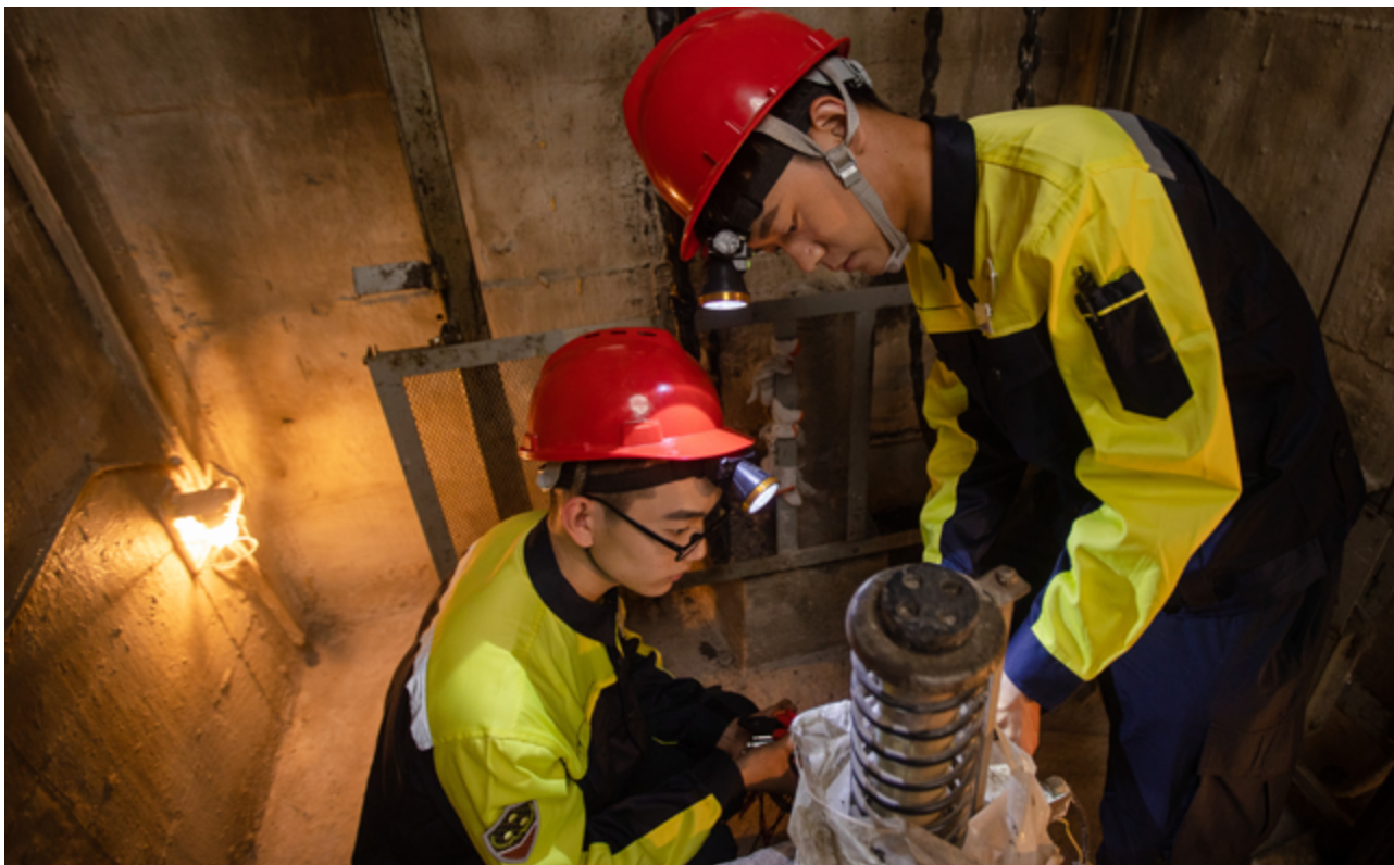
电梯底坑精调维保
